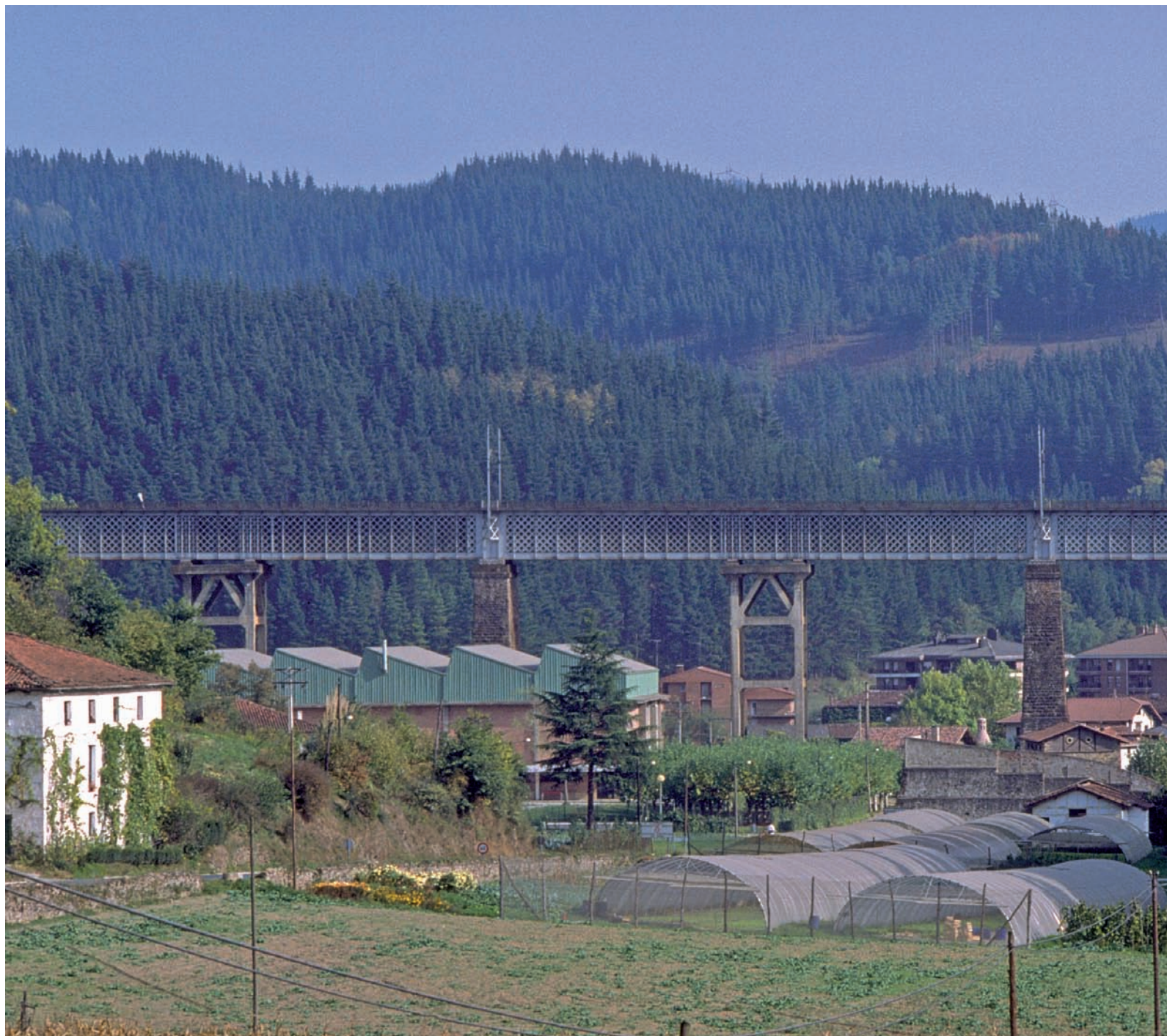
Biaduktua Ormaiztegin. / Viaducto de Ormaiztegi.
