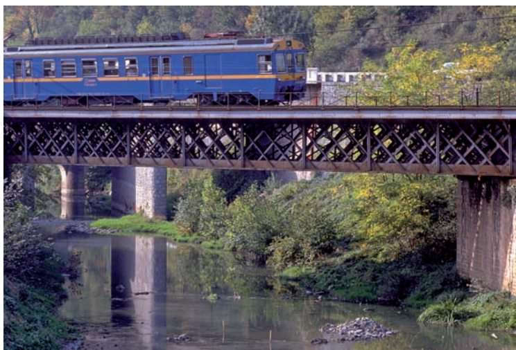
Tren-zubia Oria ibaiaren gainean, Villabonan. / Viaducto del ferrocarril en Villabona.
