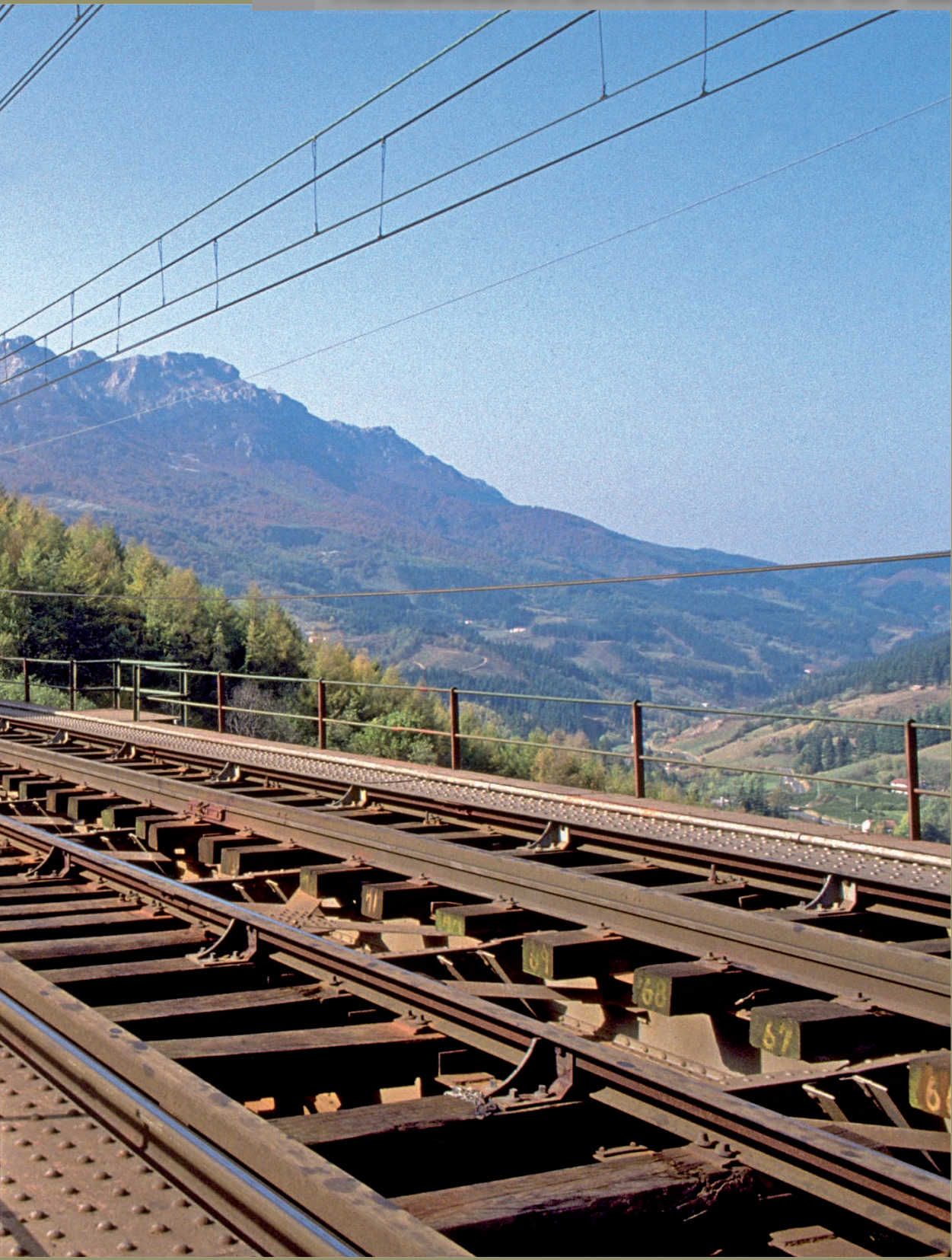
Salera erreken gaineko biaduktua Otzaurten. / Viaducto sobre el arroyo Salera en Otzaurte.
